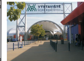
VSTUP SEVERNÍ BRÁNA NORTH GATE
