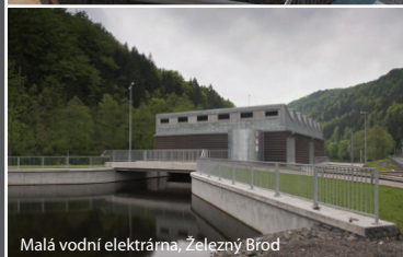
Malá vodní elektrárna, Železný Břod
